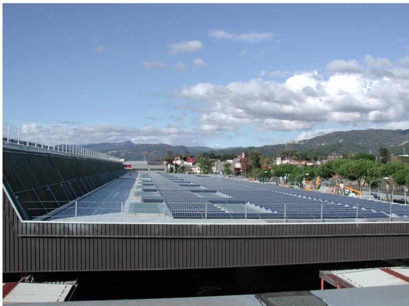
**Figura 2 – Esempio di installazione idonea alla classificazione dell’impianto fotovoltaico nella categoria “su edifici” in caso assenza di una balaustra perimetrale**
