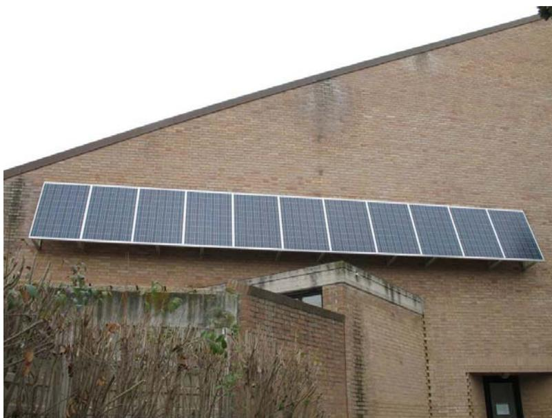
**Figura 24 - Esempio di installazione non idonea alla classificazione dell'impianto fotovoltaico nella categoria "su edifici" – Motivazione: la struttura collegata non sottende superfici trasparenti**
