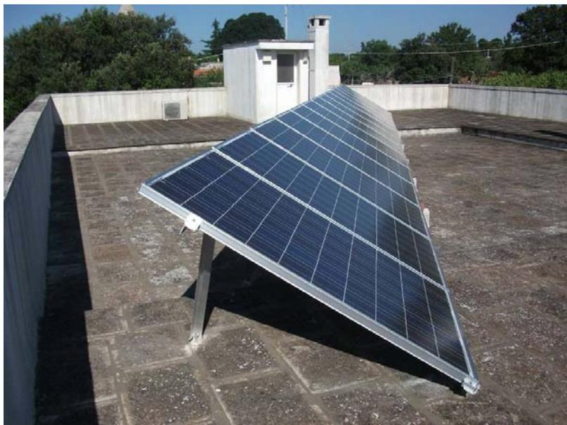
**Figura 4 – Esempio di installazione idonea alla classificazione dell’impianto fotovoltaico nella categoria “su edifici” in caso di presenza di una balaustra perimetrale**
