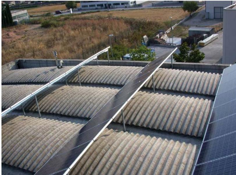
**Figura 15 - Esempio di installazione non idonea alla classificazione dell'impianto fotovoltaico nella categoria "su edifici" – Motivazione: l'inclinazione dei moduli fotovoltaici rispetto al piano tangente supera i 10°.**
