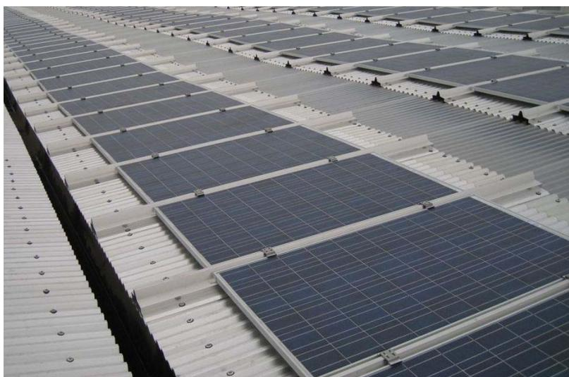
**Figura 8 – Esempio di installazione idonea alla classificazione dell’impianto fotovoltaico nella categoria “su edifici” in caso di installazione complanare su un tetto a falda senza sostituzione della superficie di copertura**
