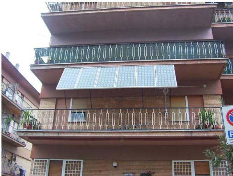
**Figura 23 - Esempio di installazione non idonea alla classificazione dell'impianto fotovoltaico nella categoria "su edifici" – Motivazione: la lunghezza dell'impianto fotovoltaico supera il doppio della lunghezza delle aperture trasparenti sottese**
