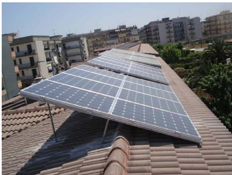
**Figura 10 - Esempio di installazione non idonea alla classificazione dell'impianto fotovoltaico nella categoria "su edifici" – Motivazione: i moduli non rispettano la geometria della falda di copertura**
